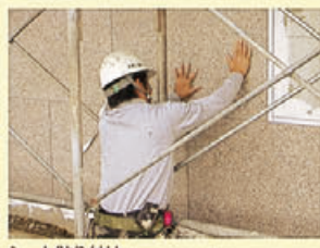
シート貼り付け
